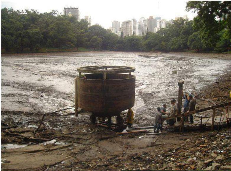
*Construção de Novos Vertedores nos Parques para Controle de Cheias Local e Redução dos Riscos de Ruptura das Barragens e aumento do Volume útil dos Reservatórios*
